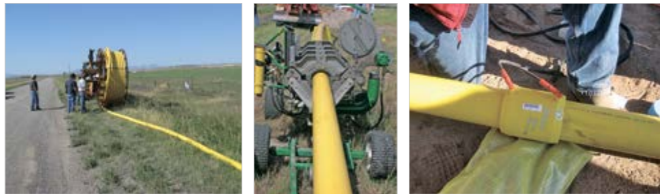
Рис. 7. Полиамид – сооружение трубопровода (бухта, сварные соединения ЭМ и ЭС)
