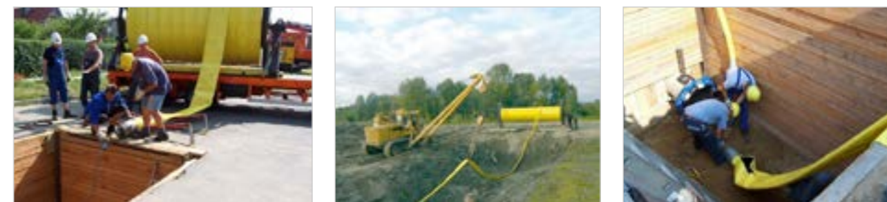
Рис. 11. Тканевый шланг высокого давления Primus Line® фирмы Rädlinger (Германия)
