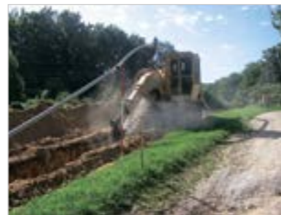
Рис. 14. Сооружение трубопровода компании E.ON с использованием продукции HexelOne®. Поставка труб в бухтах и минимально-инвазивная прокладка
