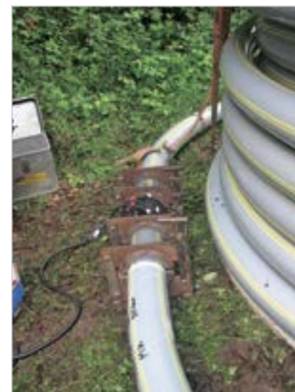
Рис. 15. Сварка участка трубопровода и укладка нитки HexelOne®
