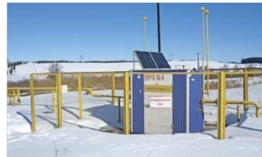
Рис. 5. ГРПБ с солнечным электрогенератором
