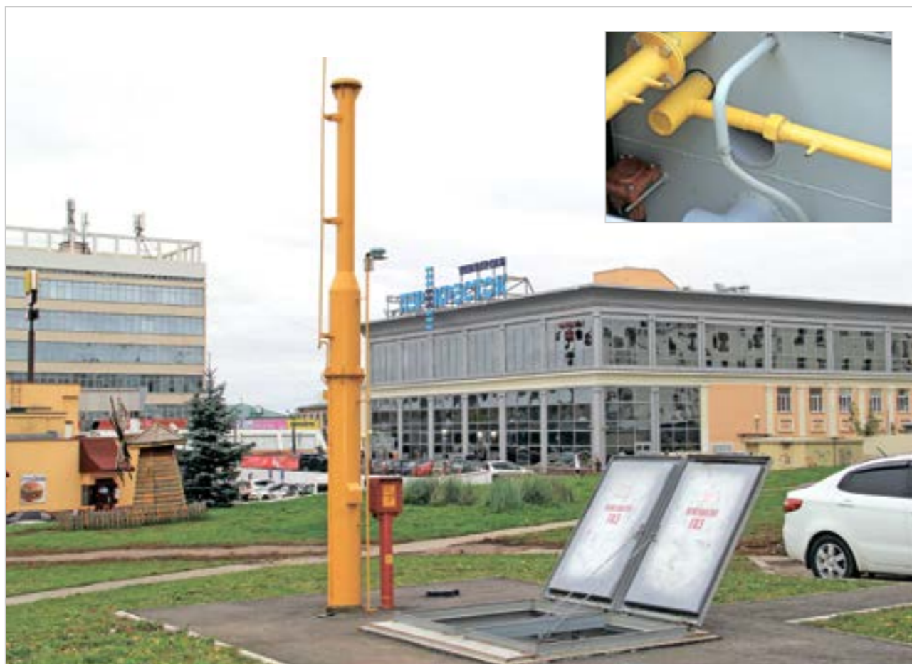
Фото 7. Продувочная мачта и узел ее присоединения
