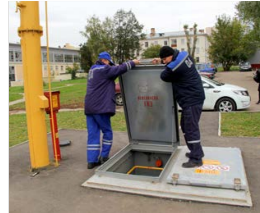
Фото 8. Крышку ПРГП можно поднять только вдвоем
