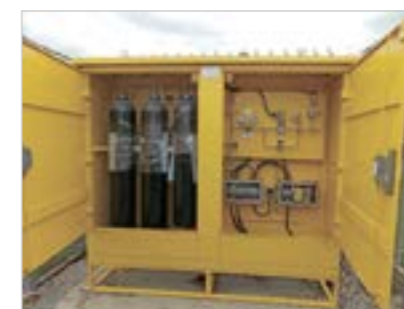
Рис. 3. Система АСДУК в шкафом исполнении
