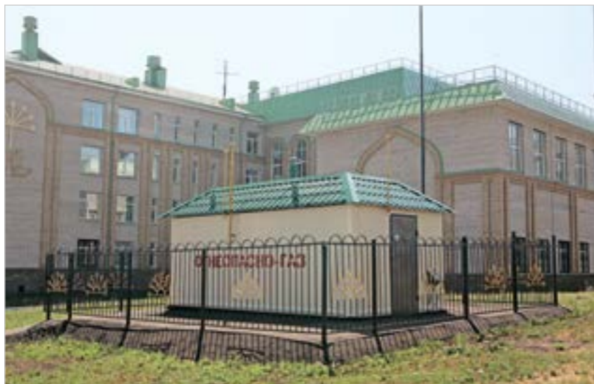
Рис. 8. ГРП ОАО «Газпром газораспределение Уфа»
