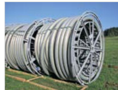
Рис. 14. Сооружение трубопровода компании E.ON с использованием продукции HexelOne®. Поставка труб в бухтах и минимально-инвазивная прокладка
