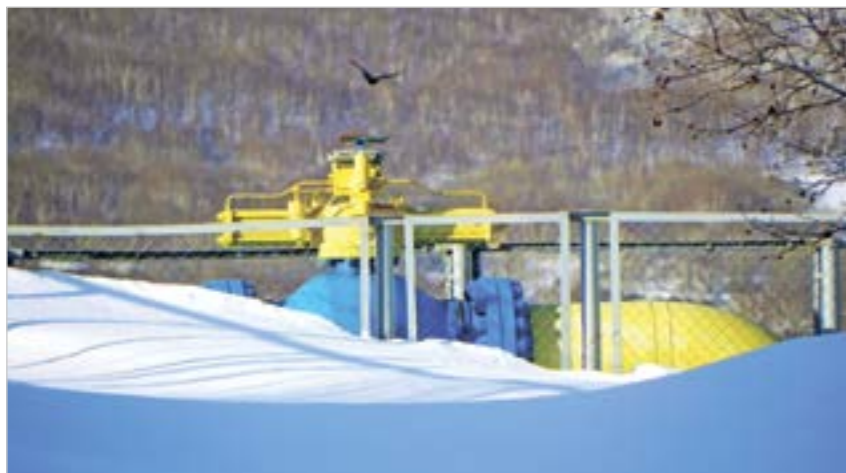
Рис. 4. Шаровый кран на газопроводе ДФО
