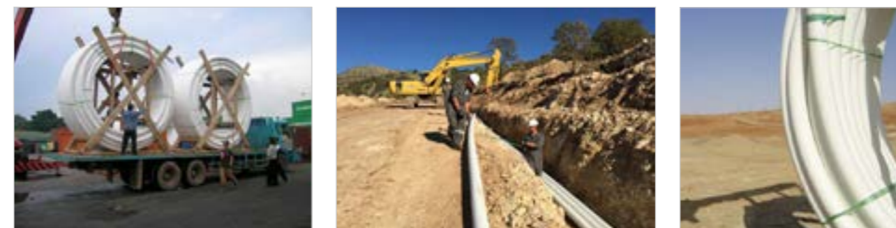
Рис. 10. Применение труб RTP фирмы Pipelife (Нидерланды) при строительстве газопроводов.
