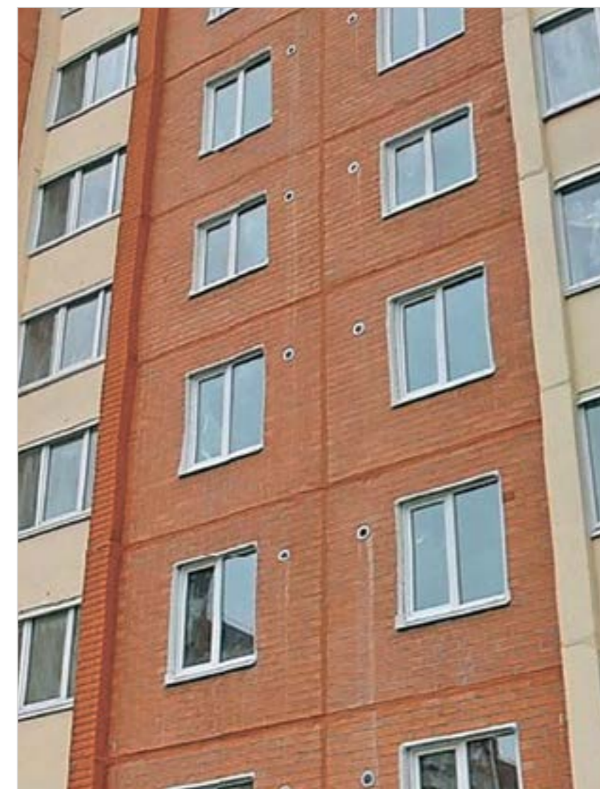
Фото 1. Санкт-Петербург. Многоквартирный дом, оборудованный стеновыми приточными клапанами
