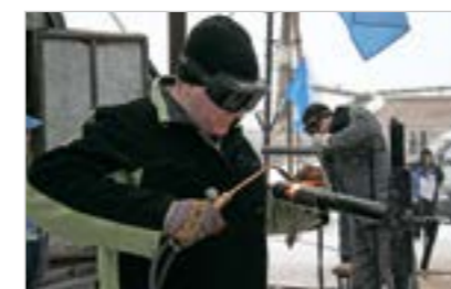
Выполнение пробного стыка трубопроводов на полигоне
