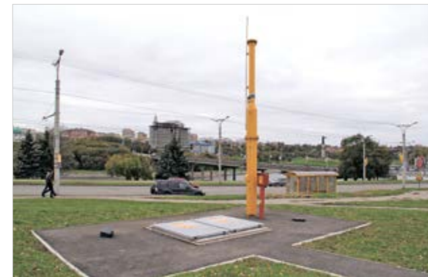
Фото 3. 21 июня 2012 г. Чебоксары, Президентский бульвар. Пункт редуцирования газа в подземном исполнении
